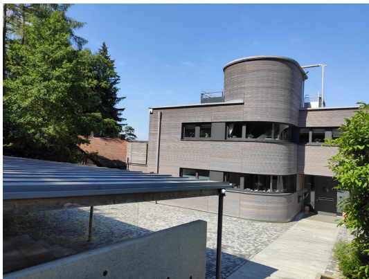
Abb. 4: Bebauung im südlichen Bereich des Planungsgebietes.
